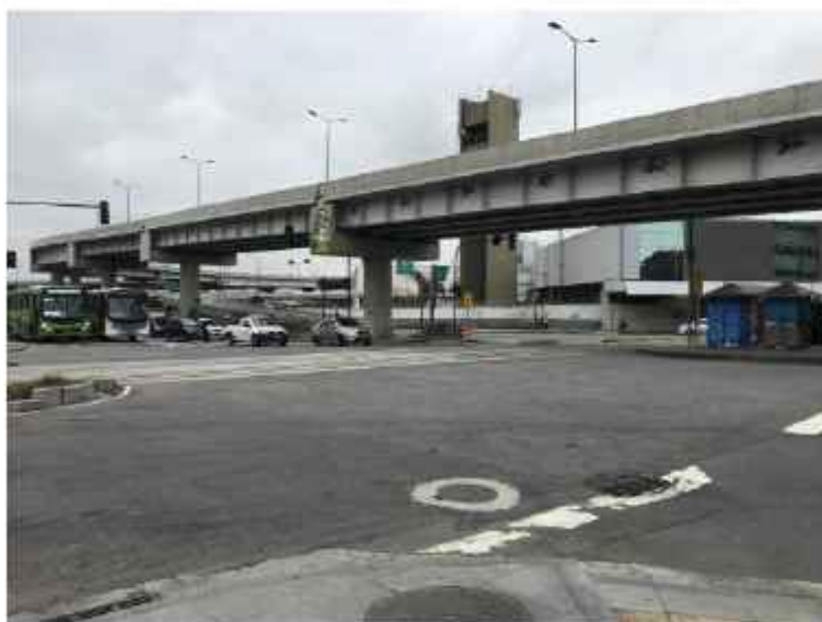
Figura 36 - Local de comércio informal debaixo do viaduto.
