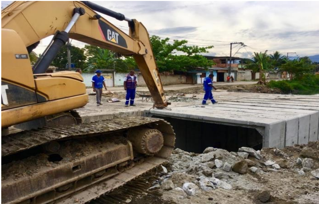
Figura 2 – Construção da galeria no Canal Farias
