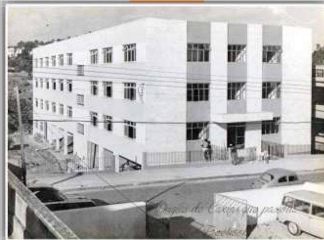
Fundação da biblioteca BIBLIAFE localizada no bloco B
