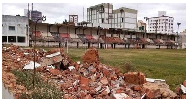
Figura 10 – Estádio Jair Siqueira Bittencourt parcialmente demolido
