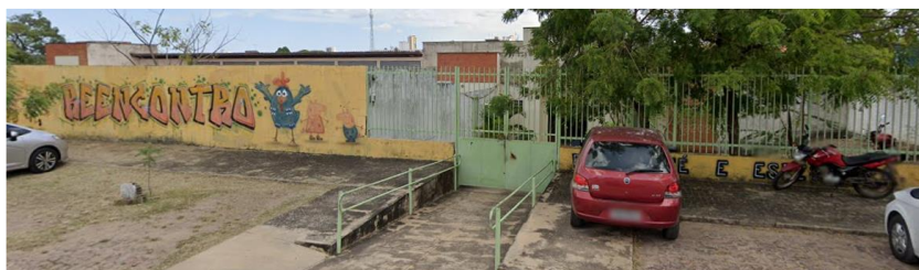
Figura 33 - Casa Reencontro vista de frente.
