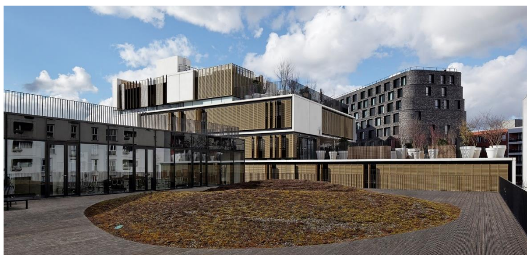
Figura 10: Vista dentro do terraço.
