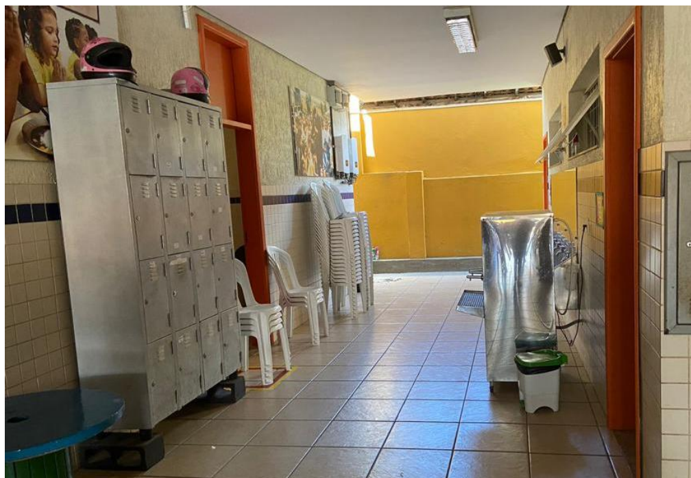
Figura 42 - Corredor com acesso pra salas multiuso.
