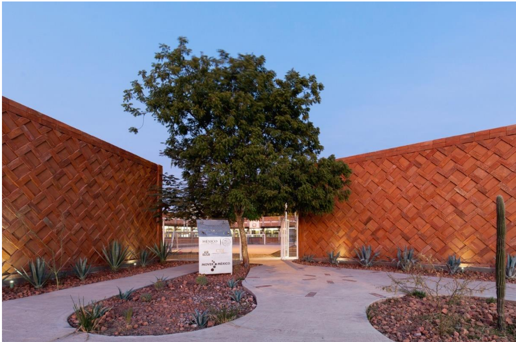
Figura 7 - Entrada principal. Acesso 1
