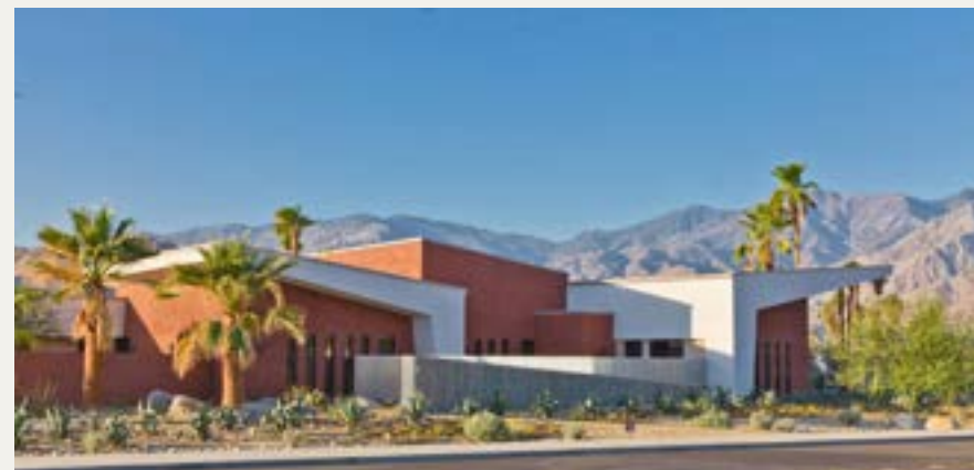
Imagem Lateral do Abrigo
