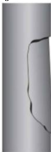
Figura 22: Ruptura longitudinal devido à pressão negativa
