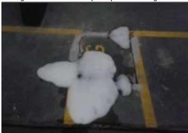
Figura 31: Retorno de espuma pela caixa de gordura
