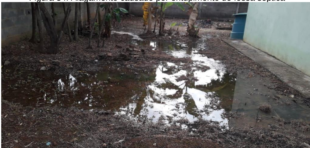
Figura 34: Alagamento causado por entupimento de fossa séptica
