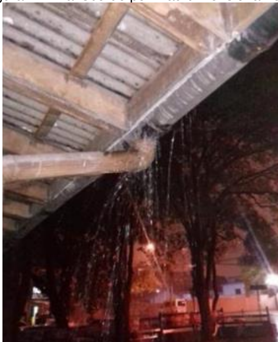
Figura 17: Transbordo por mau dimensionamento
