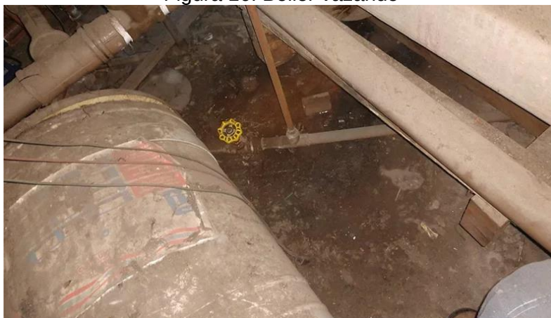
Figura 16: Boiler vazando
