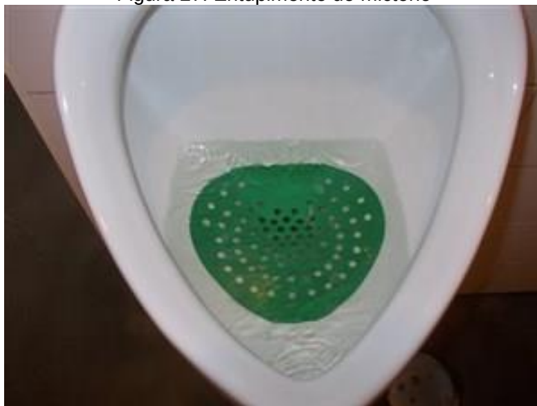
Figura 27: Entupimento do mictório
