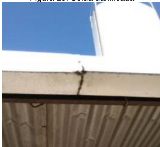
Figura 19: Solda danificada
