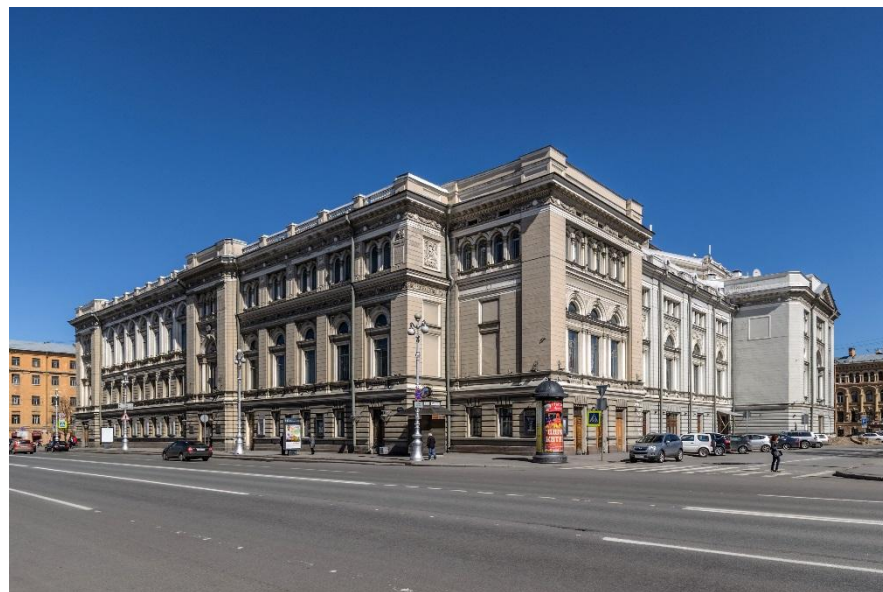
Figura 9 - Conservatório de St. Petersburg/ Fonte: Wikipedia
