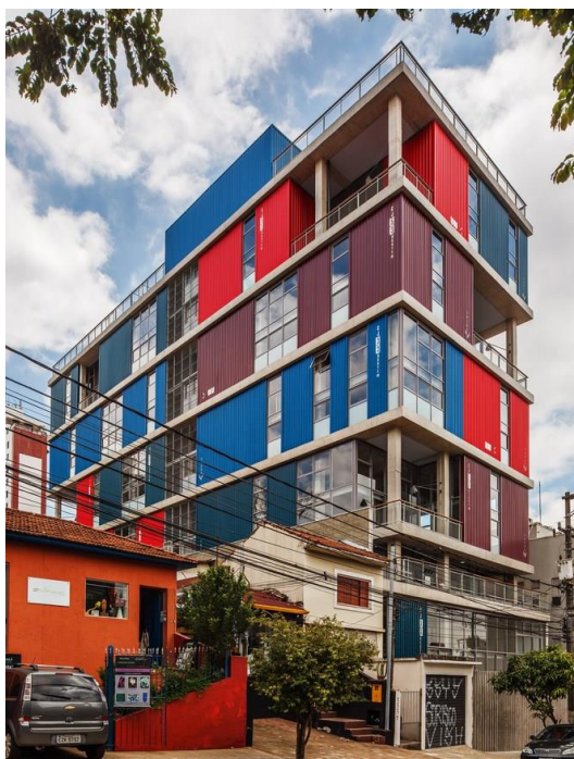
Figura 31 - Fachada do Edifício
