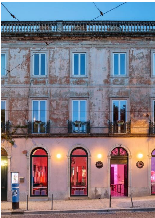
Figura 24 - Fachada do Edifício Pombalino com o Restobar LULU
