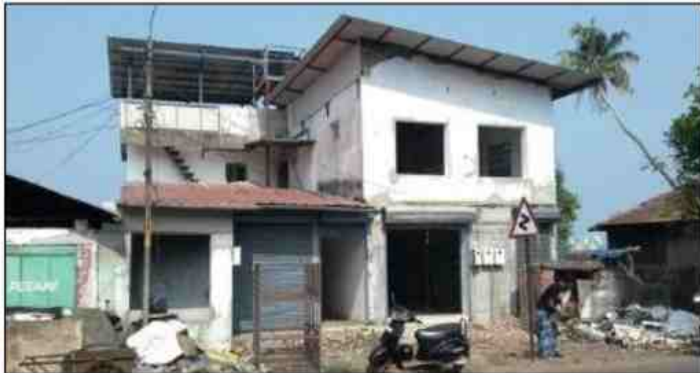
Figura 33 – Fachada principal durante a reforma
