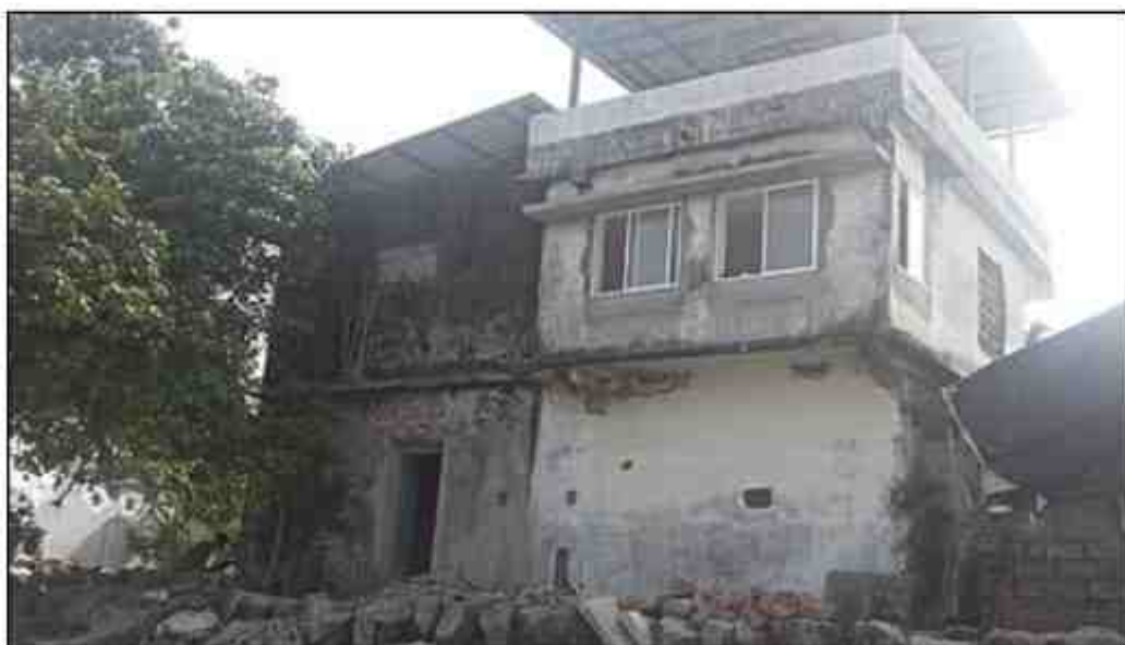
Figura 34 – Fachada posterior durante a reforma
