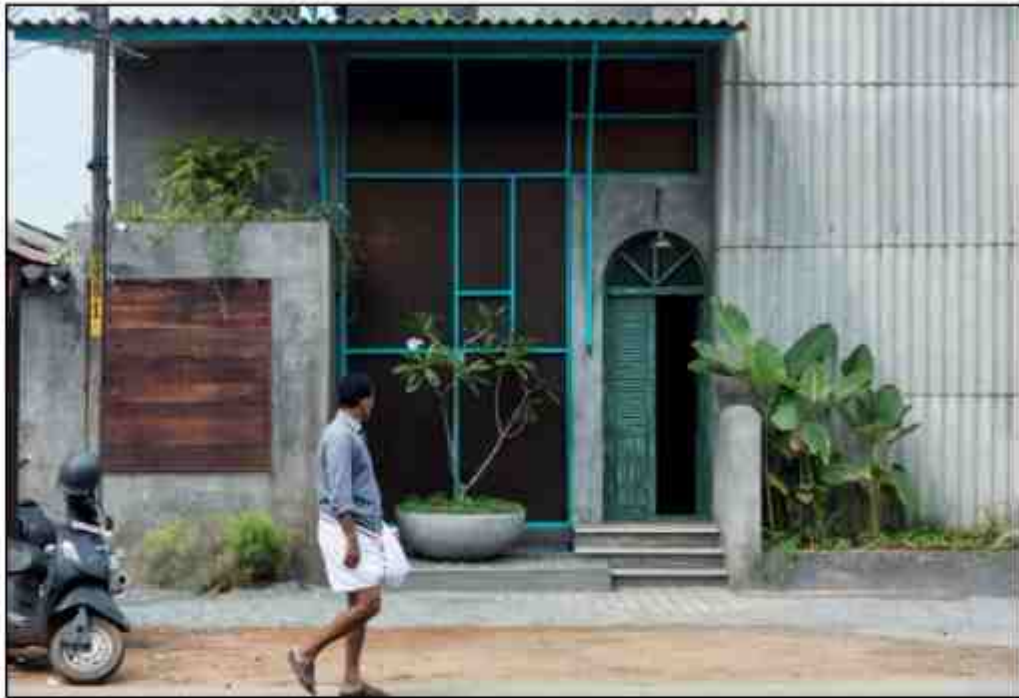
Figura 35 – Fachada principal após a reforma
