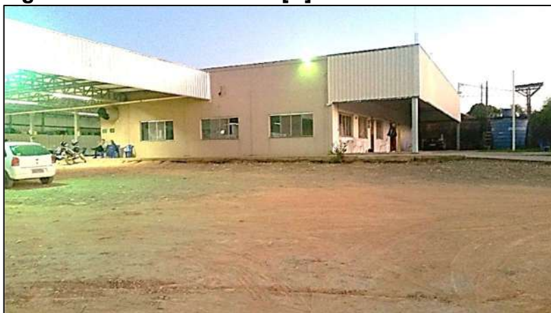
Figura 98: Foto do terreno [A].
