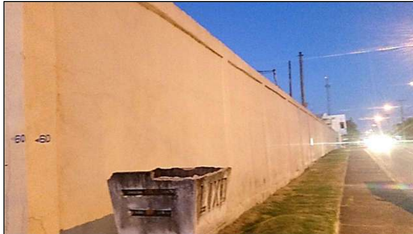
Figura 163: Vista da Rua Dom Augusto.
