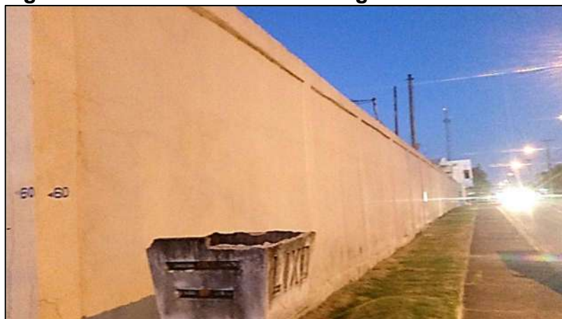
Figura 101: Vista da Rua Dom Augusto.
