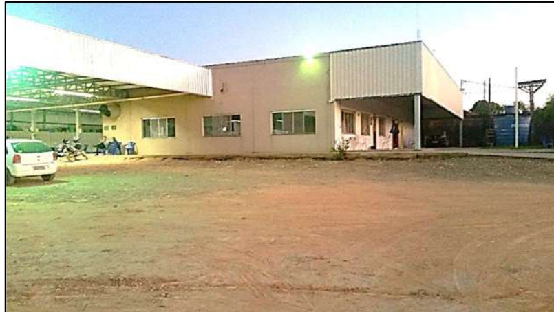
Figura 160: Foto do terreno [A].
