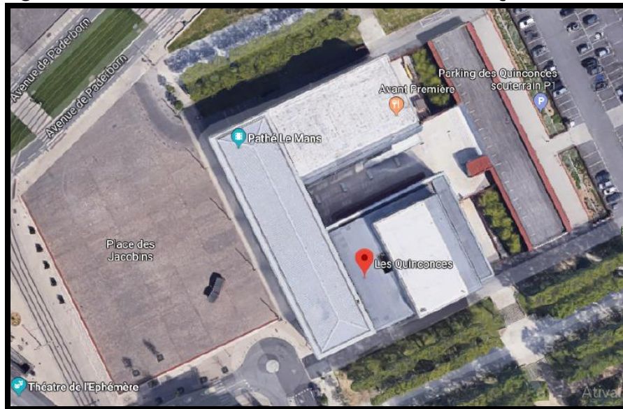
Figura 20 - Vista aérea do Centro Cultural Les Quinconces
