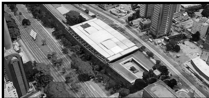
Figura 11 – Vista aérea, Centro Cultural São Paulo
