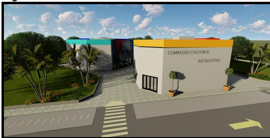
Figura 41 – Fachada Bloco Administrativa
