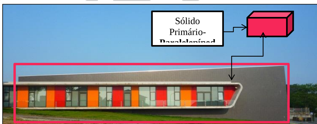
Figura 10 – Fachada Escola Municipal de Dança de Oleiros
