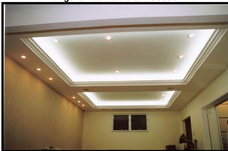
Figura 100. Forro em Gesso
