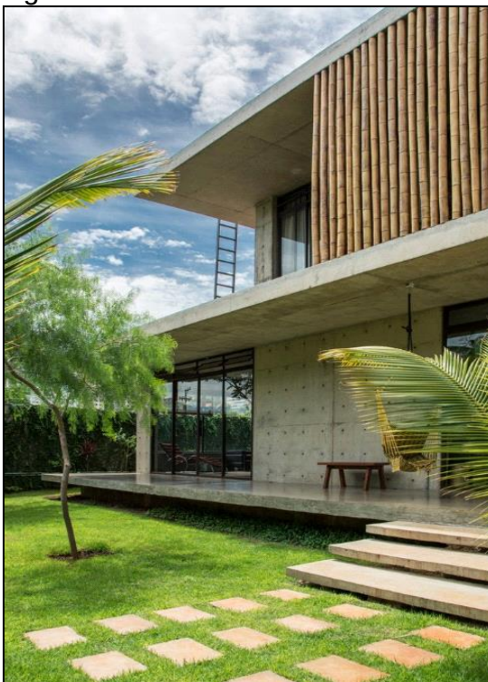
Figura 46 - Fachada Lateral Casa Petro
