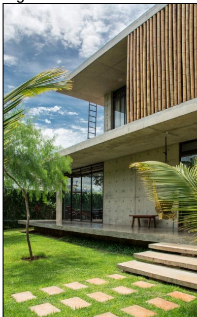
Figura 18: Fachada Lateral Casa Petro.
