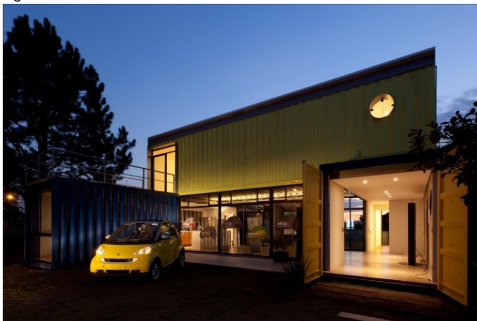
Figura 51 – Fachada frontal da casa container
