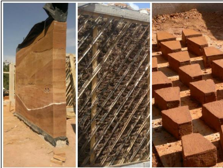
Figura 57 - Técnicas construtivas da casa responsável
