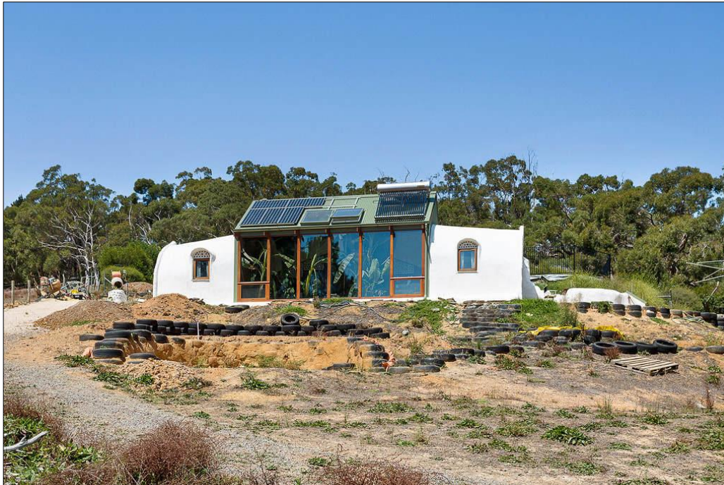
Figura 15: Fachada Frontal da Residência Solar.
