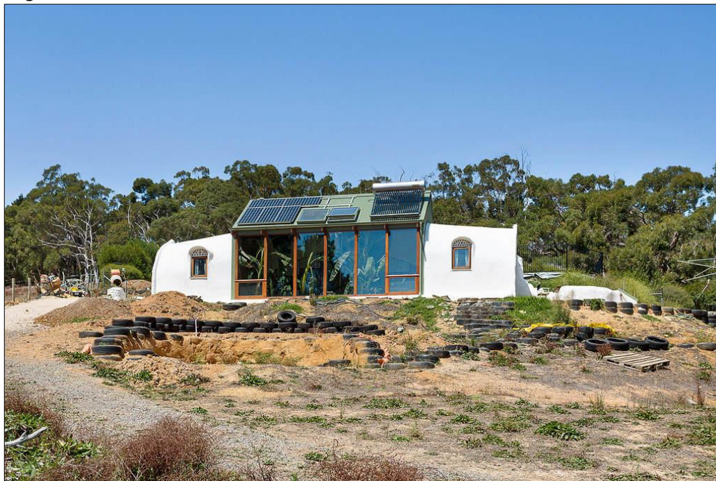
Figura 43 - Fachada Frontal da Residência Solar
