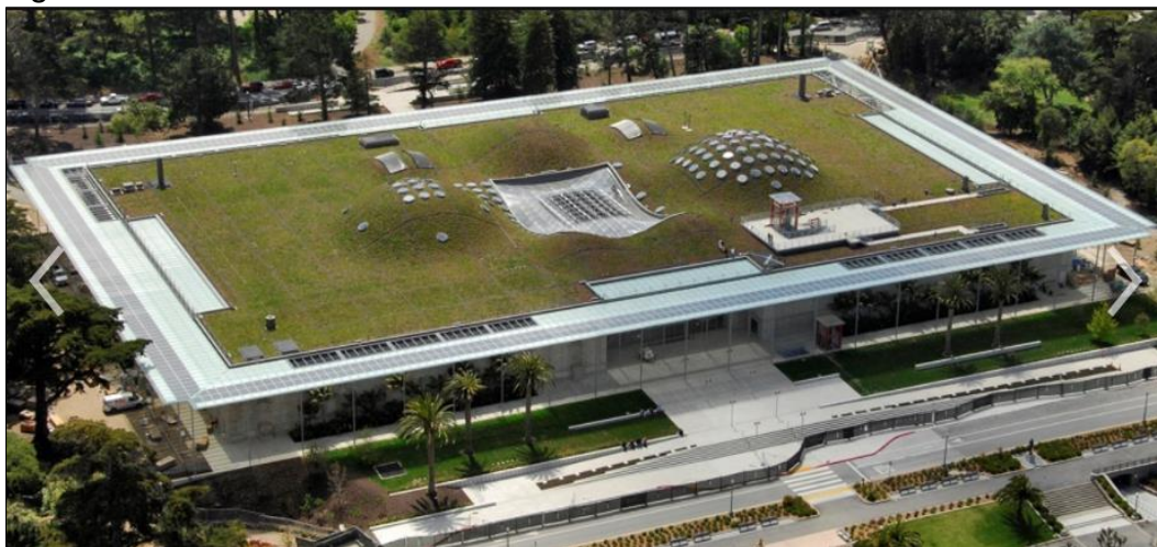
Figura 36 - Vista aérea da academia das ciências da Califórnia
