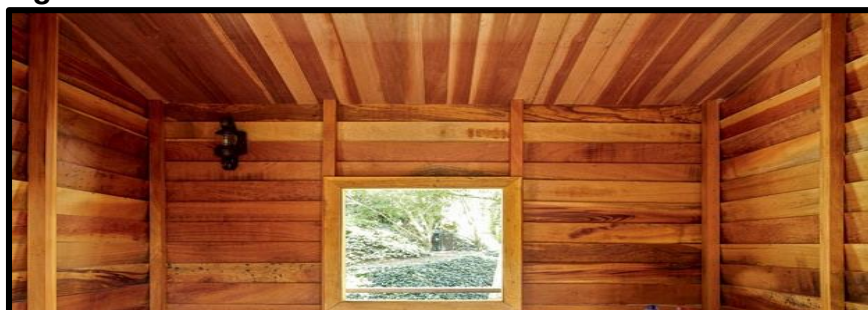
Figura 84: Madeira de Reflorestamento na estrutura
