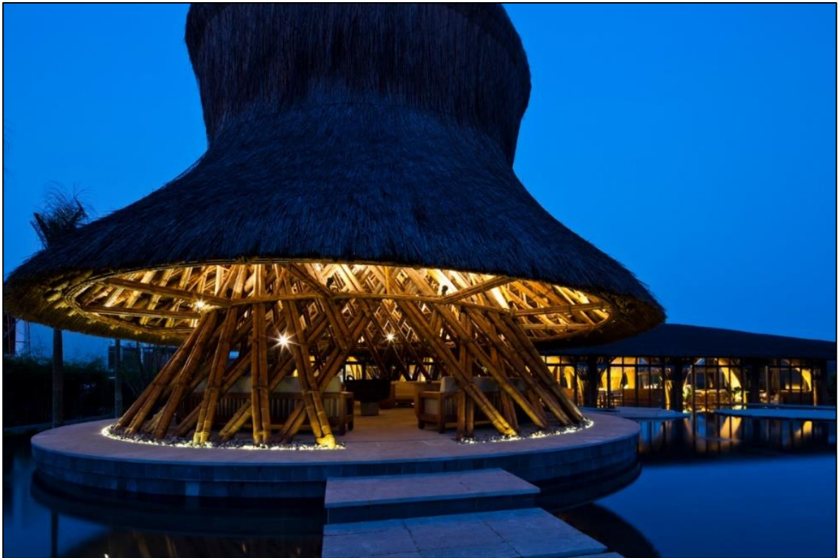
Figura 25- Entrada do restaurante
