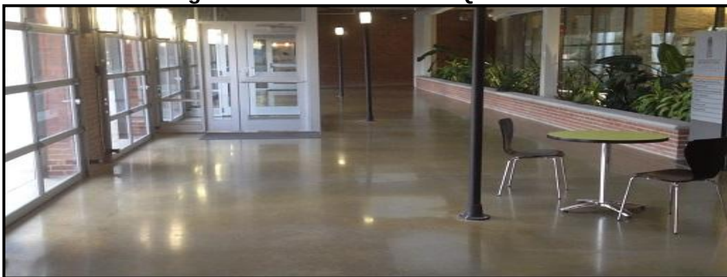
Figura 52: Piso de Cimento Queimado
