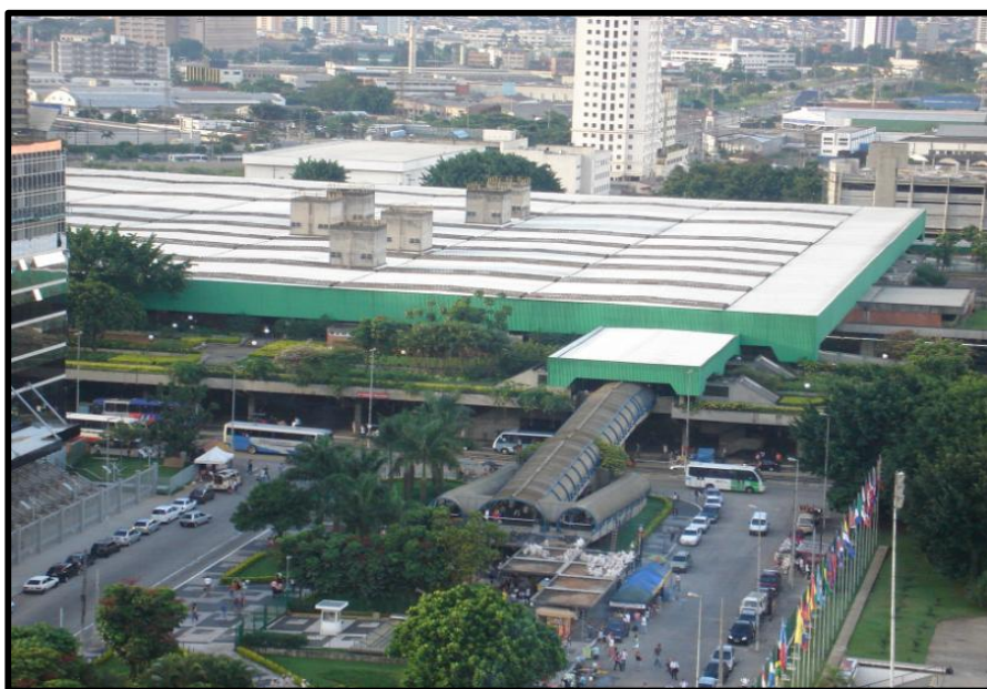
Figura 35: Acessos ao Terminal Tietê
