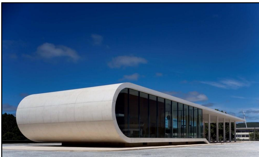
Figura 26: Terminal Rodoviário em Rio Maior
