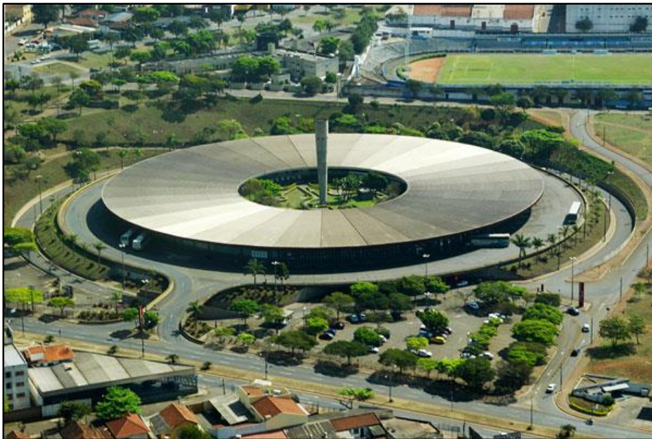
Figura 05: Terminal Rodoviário Garcia Villar
