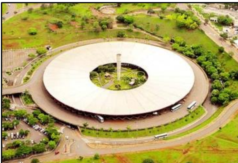
Figura 37: Terminal Rodoviário Garcia Villar
