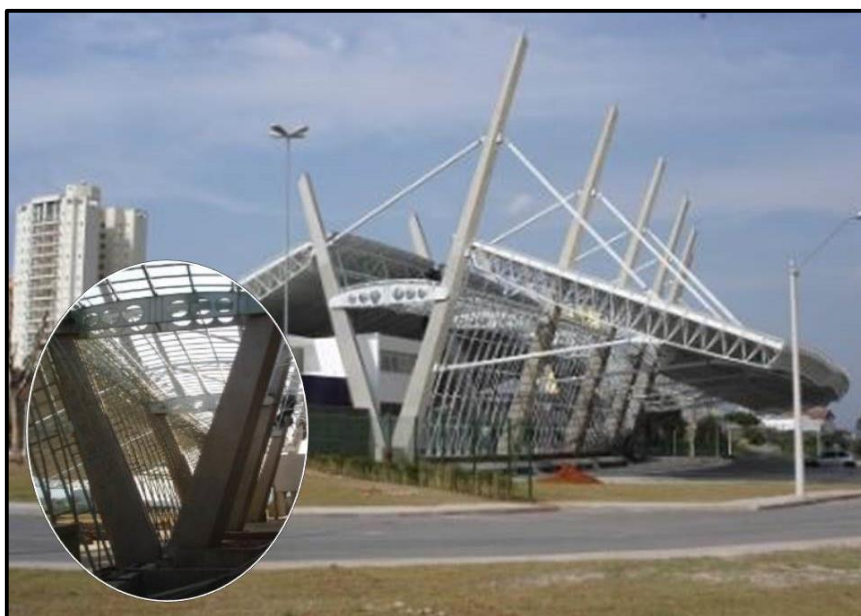
Figura 44: Pilares Inclinados - Terminal Rodoviário José Alves
