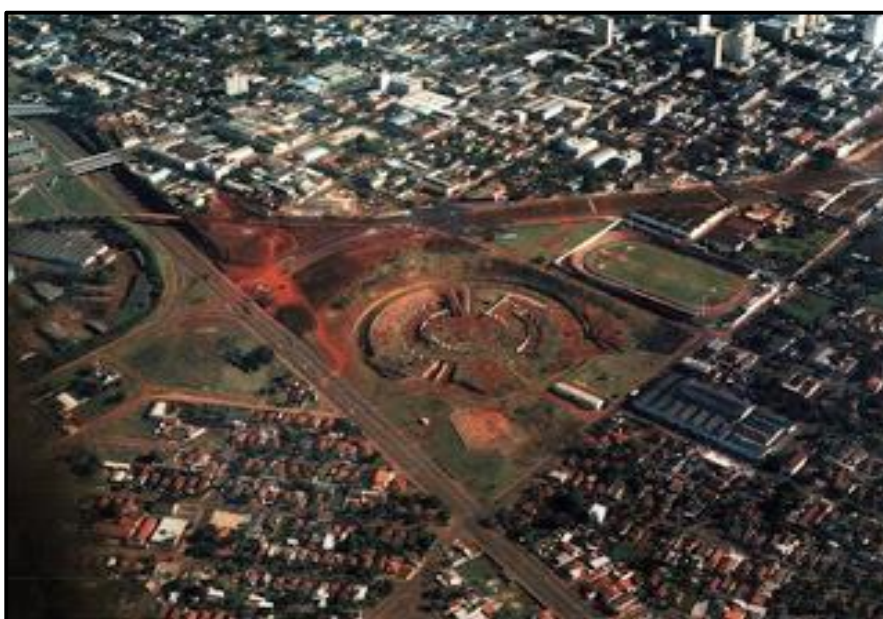
Figura 38: Terreno - Terminal Rodoviário Garcia Villar
