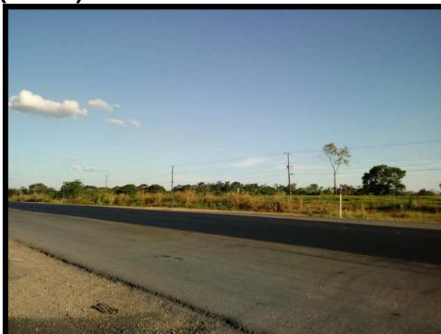
Figura 83 - Vista da Rodovia Federal BR-364 (frontal)
