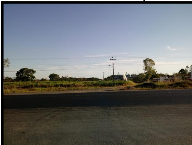
Figura 84 - Vista da Rodovia Federal BR-364 no encontro com o Anel Viário (vista frontal).
