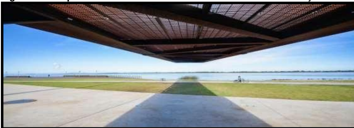
Figura 45 Parque Urbano da Orla do Guaíba Plataforma em balanço
