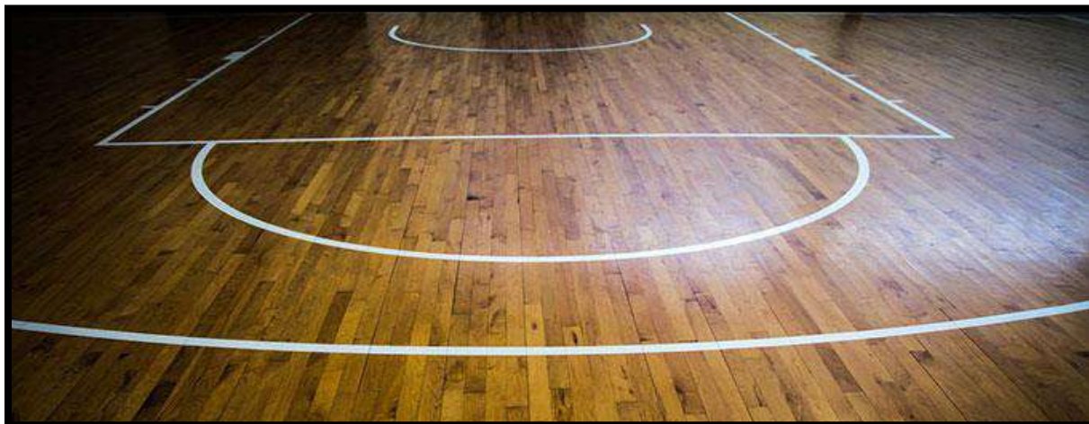
Figura 123 – Piso de madeira
