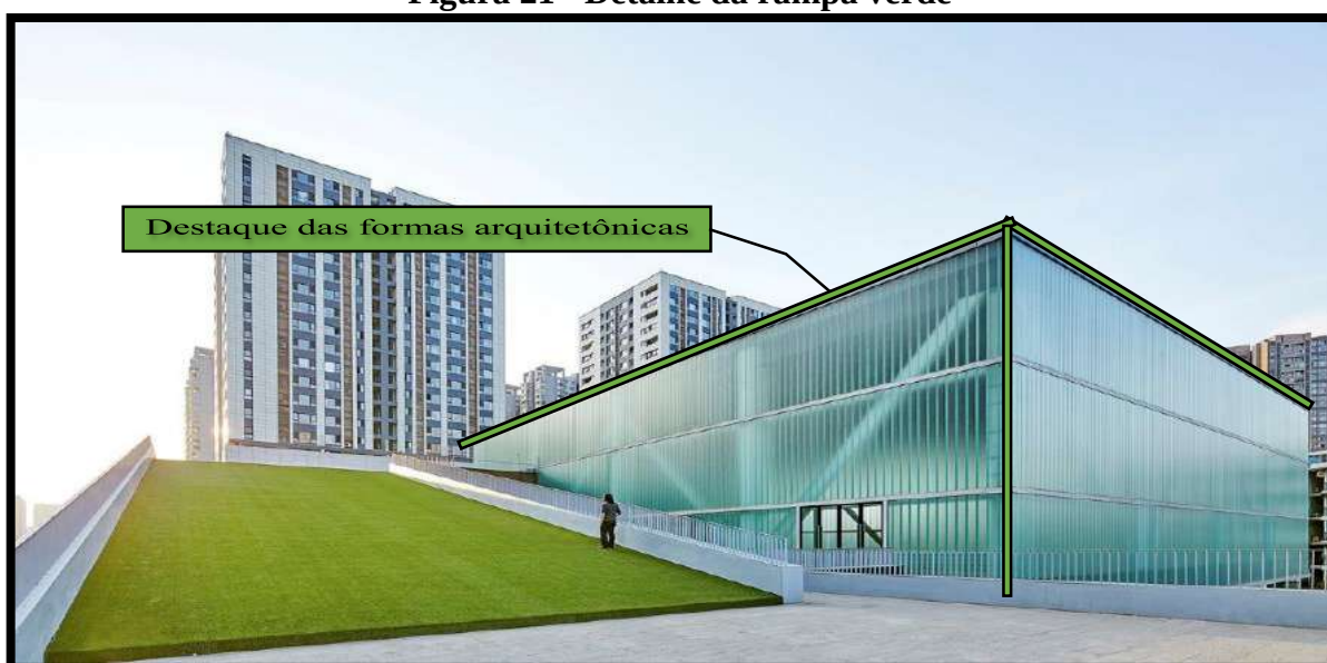
Figura 21 - Detalhe da rampa verde
