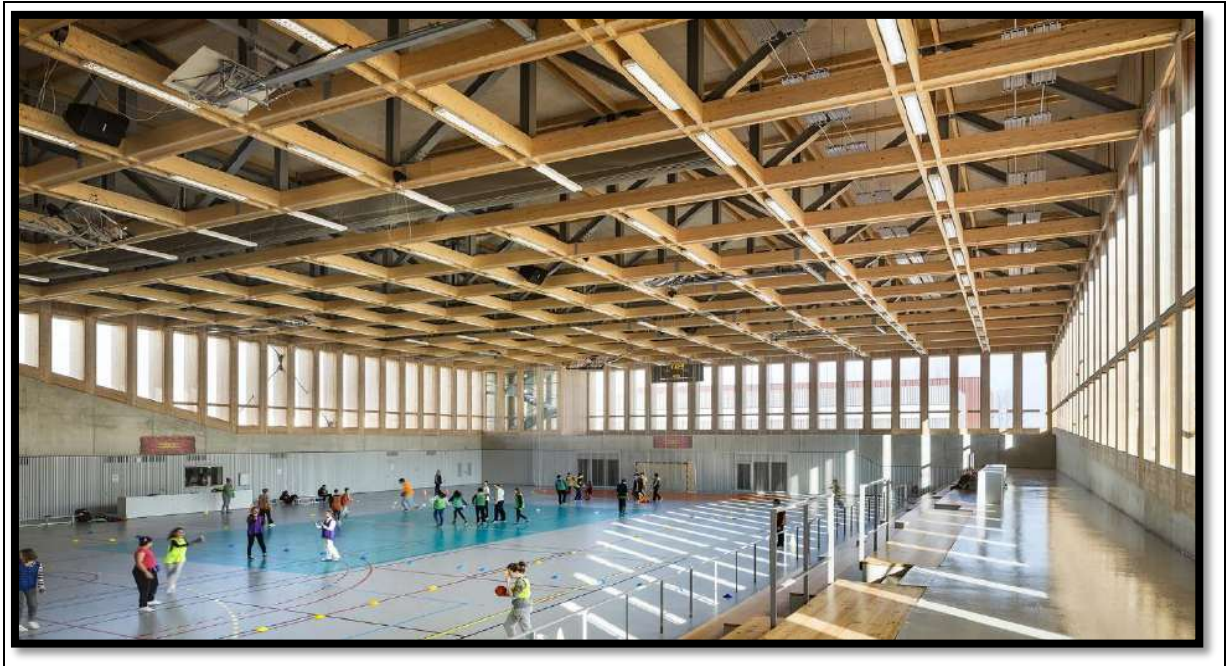
Figura 142 – Detalhe do telhado e quadra poliesportiva
