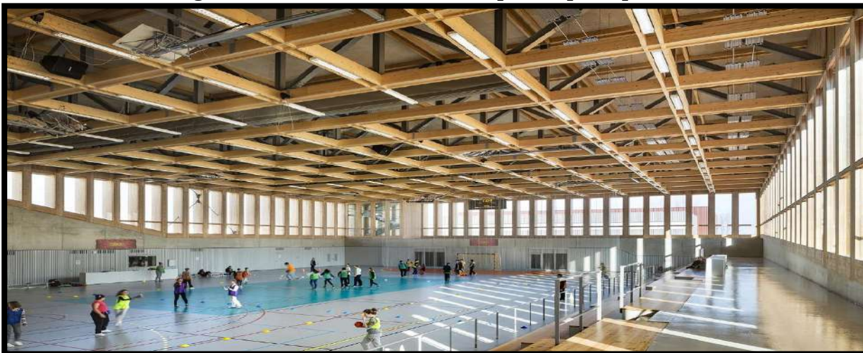
Figura 36 – Detalhe do telhado e quadra poliesportiva
