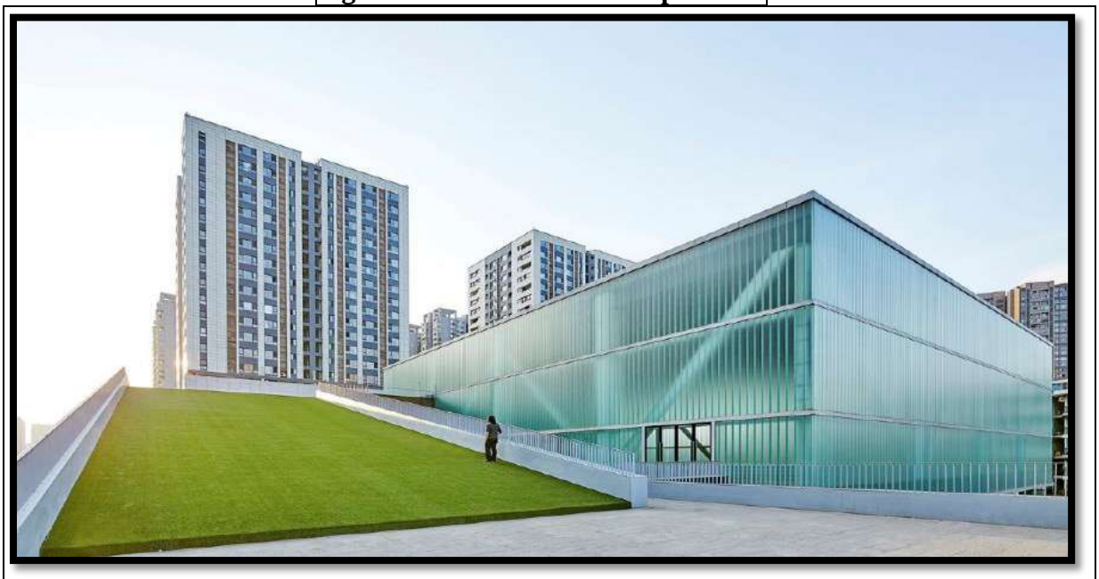
Figura 128 - Detalhe da rampa verde
