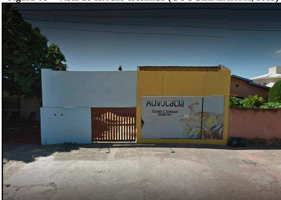
Figura 06 – Vista do terreno escolhido (GOOGLE EARTH, 2019)
