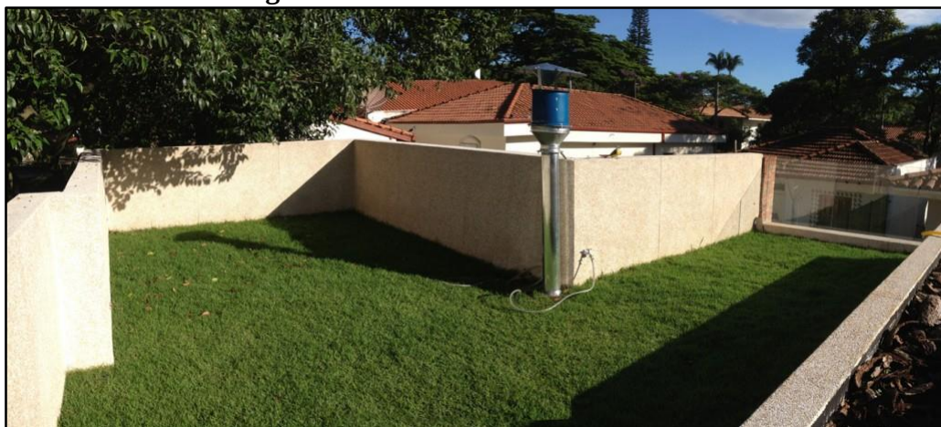
Figura 35 - Cobertura Telhado Verde
