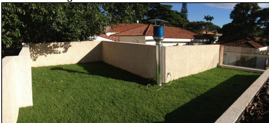
Figura 23: Cobertura Telhado Verde
