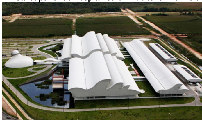
Figura 57: Vista superior do hospital Sarah Kubitchek no Rio de Janeiro.
