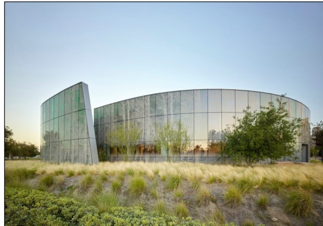
Figura 24: Fachada do Centro Oncológico Kraemer
