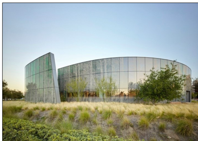
Figura 5 - Fachada do Centro Oncológico Kraemer
