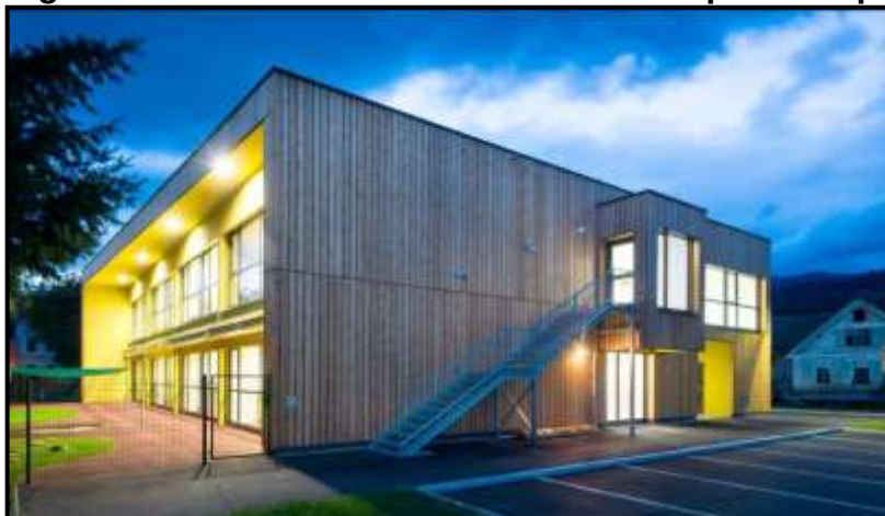
Figura 72: Escada metálica de acesso ao primeiro pavimento.
