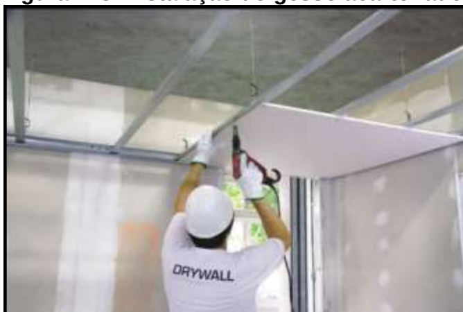
Figura 128: Instalação do gesso acartonado.
