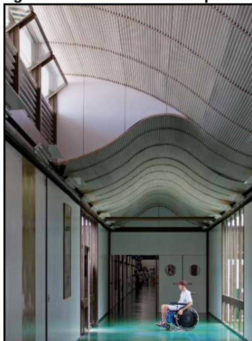
Figura 82: Painéis curvos tipo shed.
