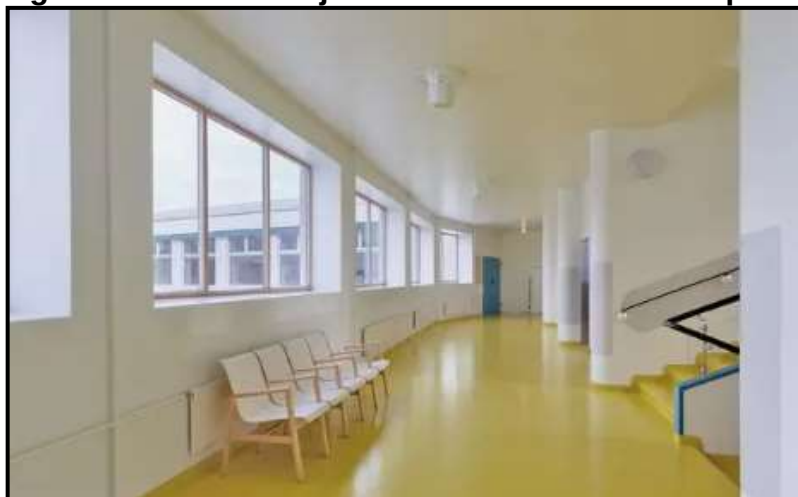
Figura 123: Grandes janelas em corredores hospitalares.
