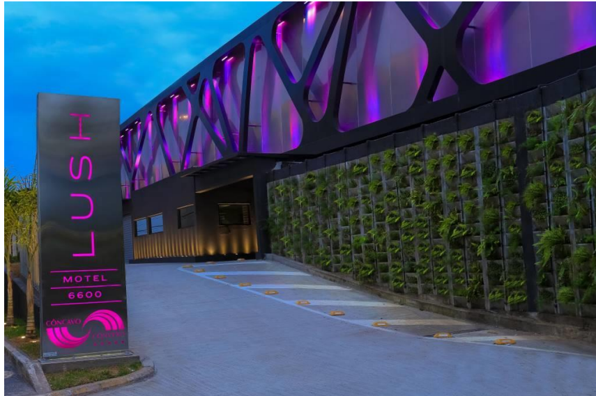
Figura 31 – Entrada Lush Motel. Fonte: http://lushmotel.com.br/
