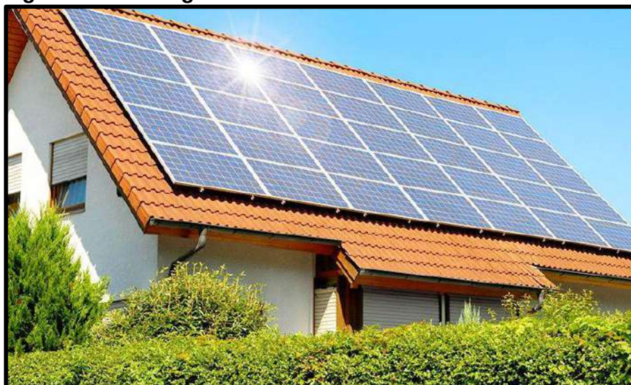
Figura 114– Energia solar fotovoltaica
