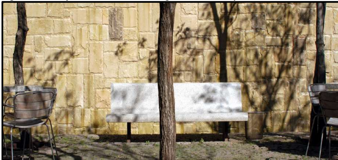
Figura 15 - Praça da Amarui, fios de água descem na parede.
