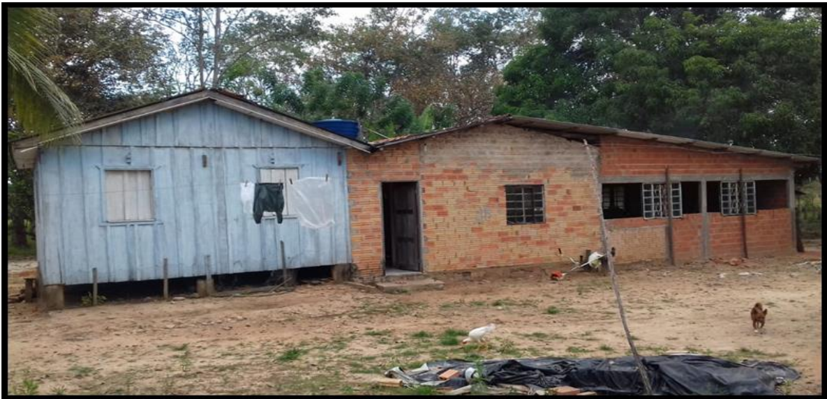
Fig. 54- Edificações existentes no lote.
