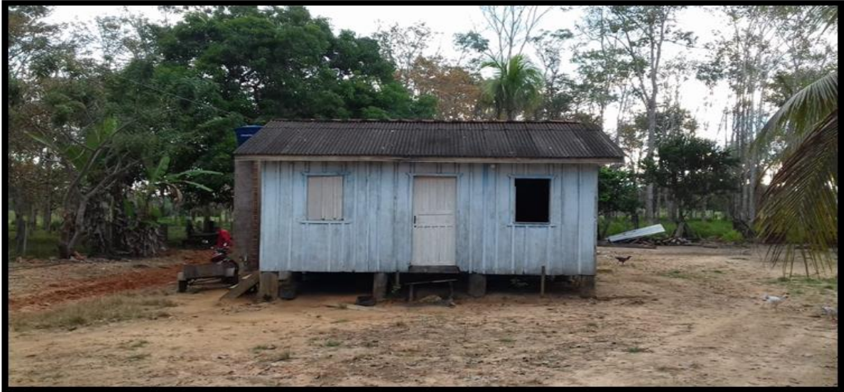
Fig. 53- Vista lateral das edificações existentes.
