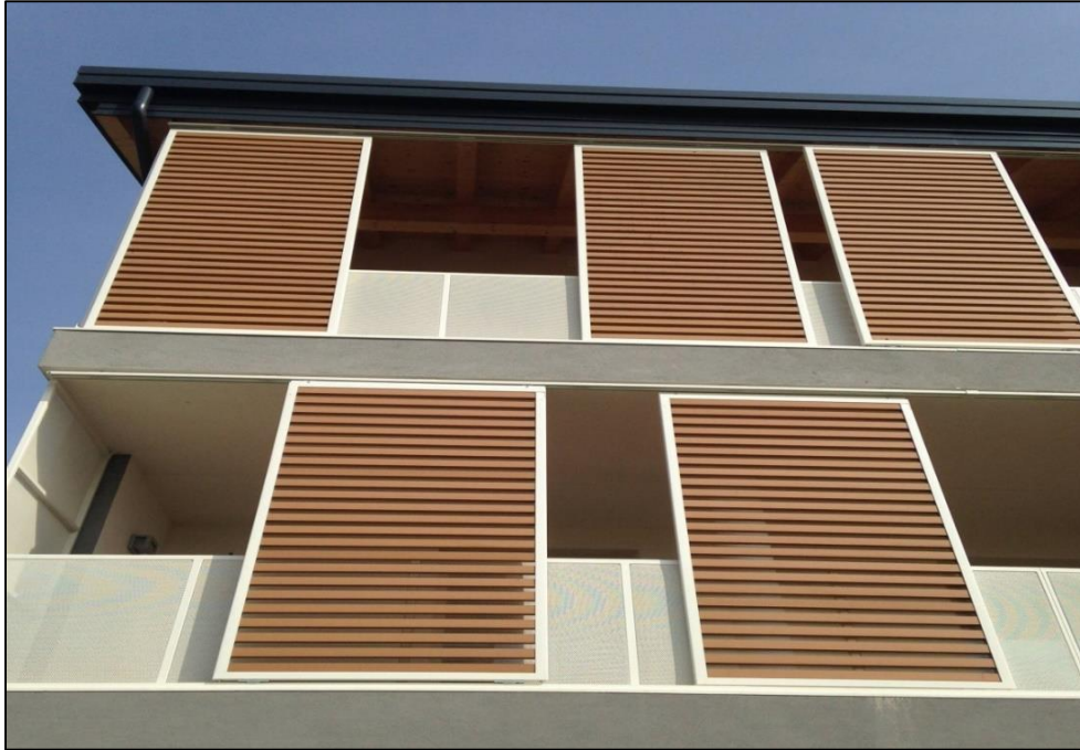
Figura 117: Aplicação de brises em fachada
