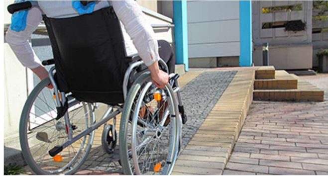
Figura 101 - Rampa de acessibilidade
