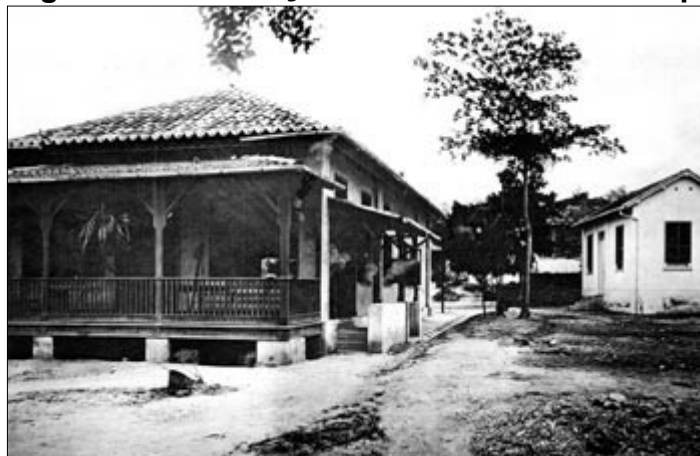
Figura 13 - Instalações do Instituto Soroterápico federal
