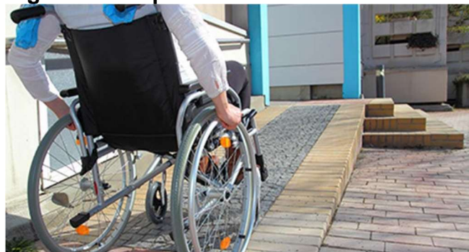
Figura - Rampa de acessibilidade
