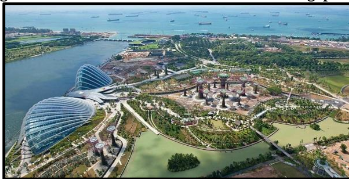
Figura 40: Vista Aérea Jardim Botânico de Cingapura
