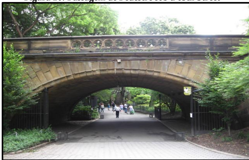
Figura 26: Passagem de Pedestre sob a 65th Street
