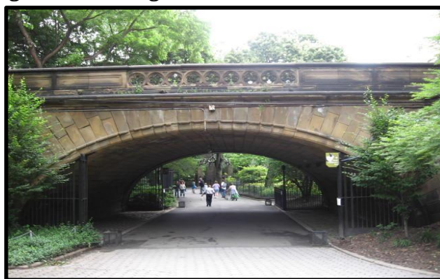
Figura 32: Passagem de Pedestre sob a 65th Street
