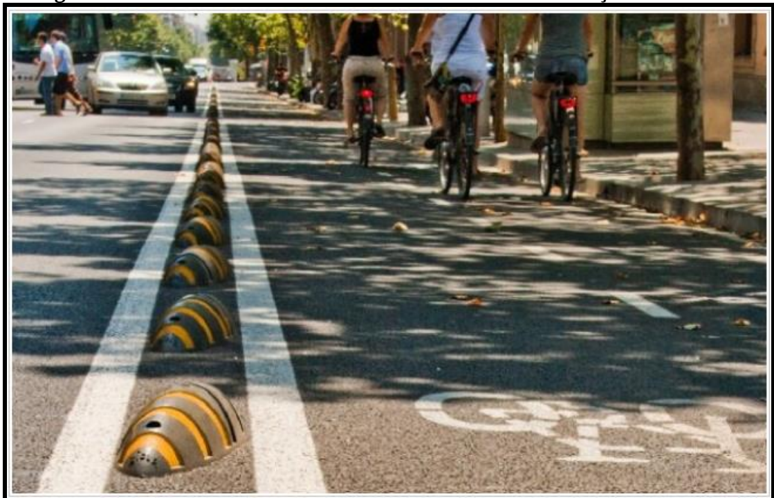
Figura 72. Armadillos: sustentabilidade também na construção de ciclovias
