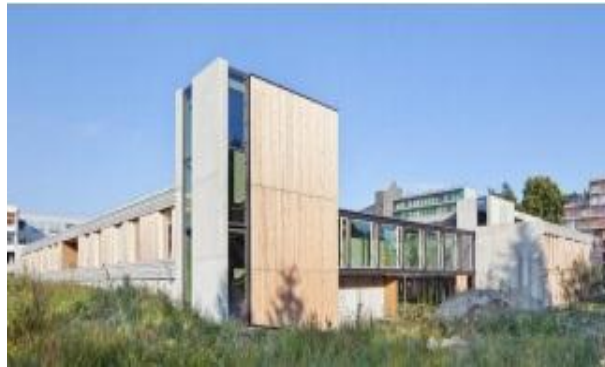
Figura 9: Centro Psiquiátrico Friedrichshafen
