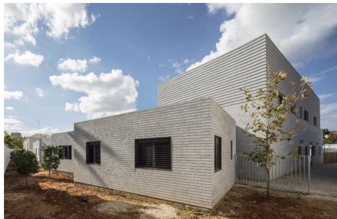
Figura 06: Fechada externa protetora
