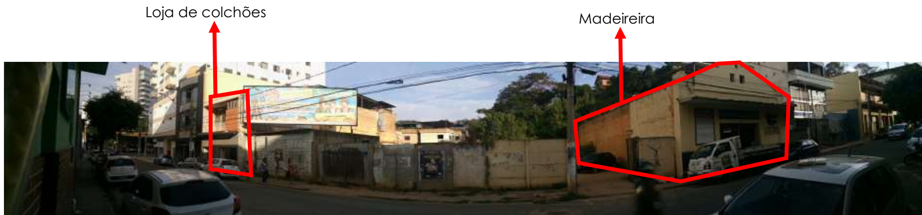
Figura 13 – indicação dos imóveis a serem demolidos. Fonte: Acervo pessoal.
