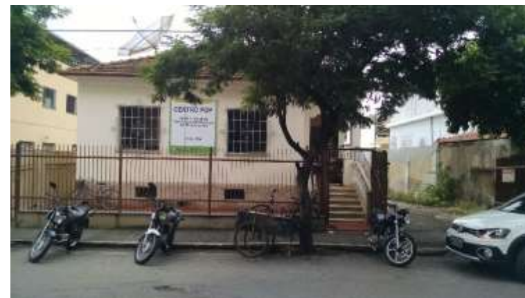
Figura 41 – Fachada Centro POP de Ubá Fonte: Acervo pessoal
