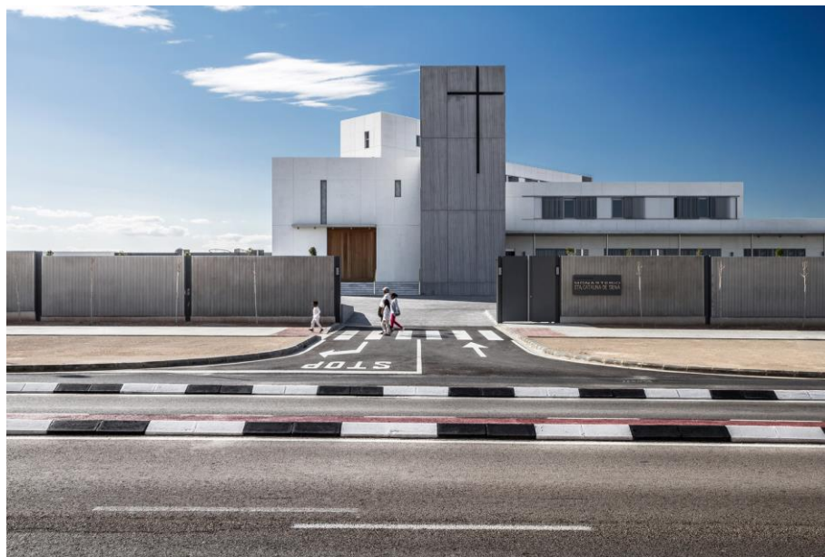
Figura 42 Fachada frontal do Mosteiro, mostrando o destaque causado pela igreja
