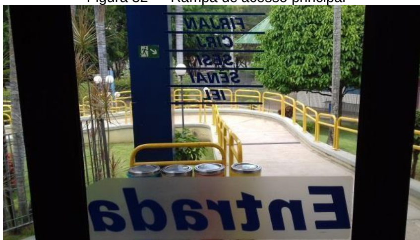
Figura 32 — Rampa de acesso principal
