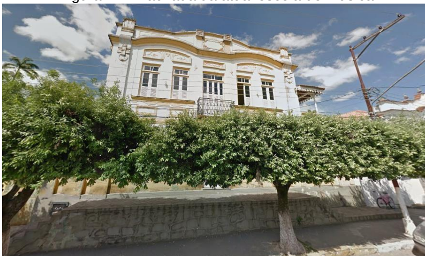
Figura 1 — Fachada da atual escola de música
