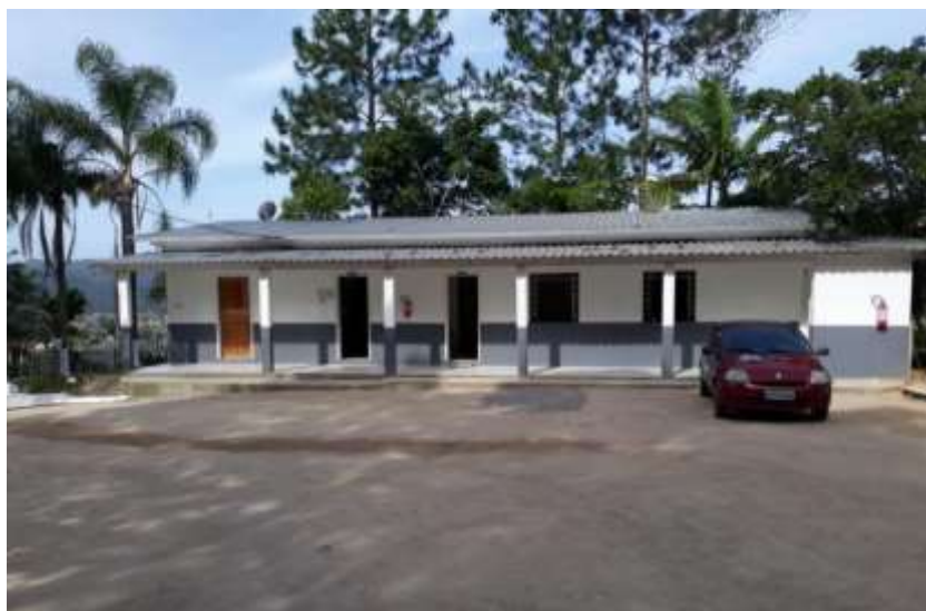
Figura 15 Bloco Administrativo CADQ Fonte: Thiago Pessetti
