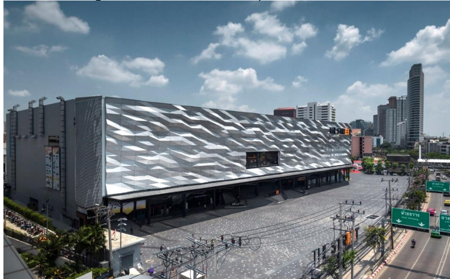
Figura 24. Fachada com parte do entorno.
