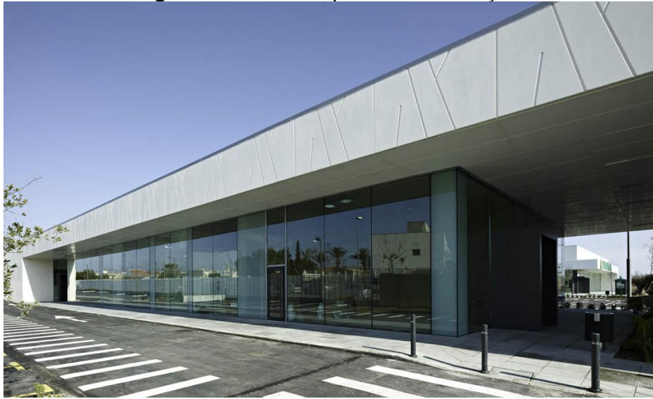
Figura 18. Vista de parte da edificação.
