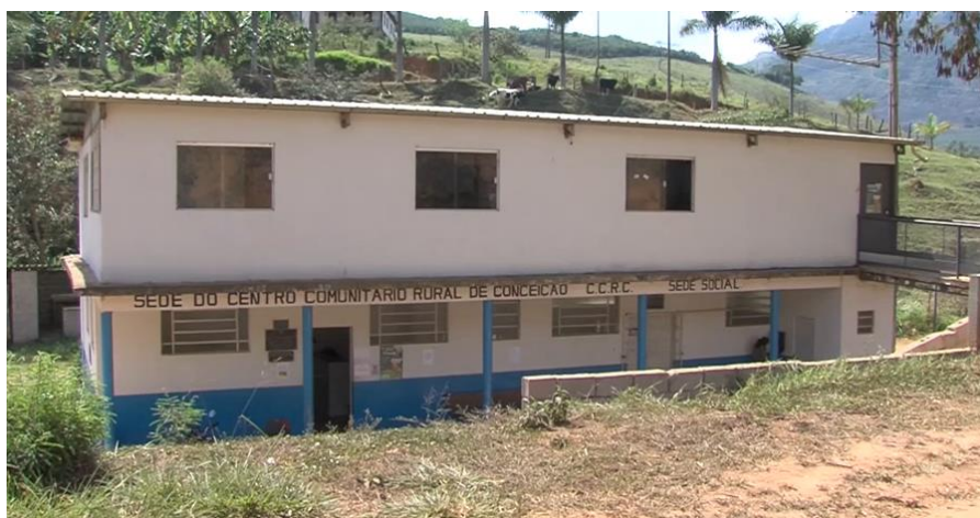
Figura 2 – Centro Comunitário Rural de Conceição (CCRC).
