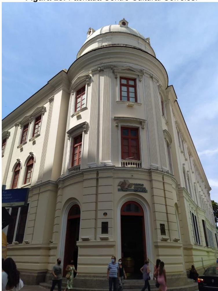
Figura 15: Fachada Centro Cultural Correios.
