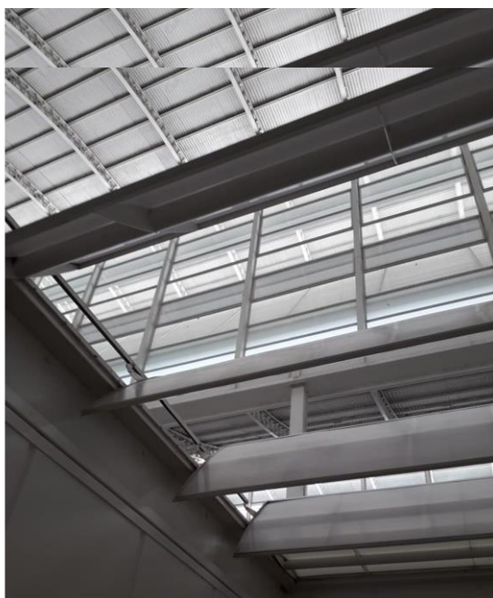
Figura 10 – Detalhe brise aberto
