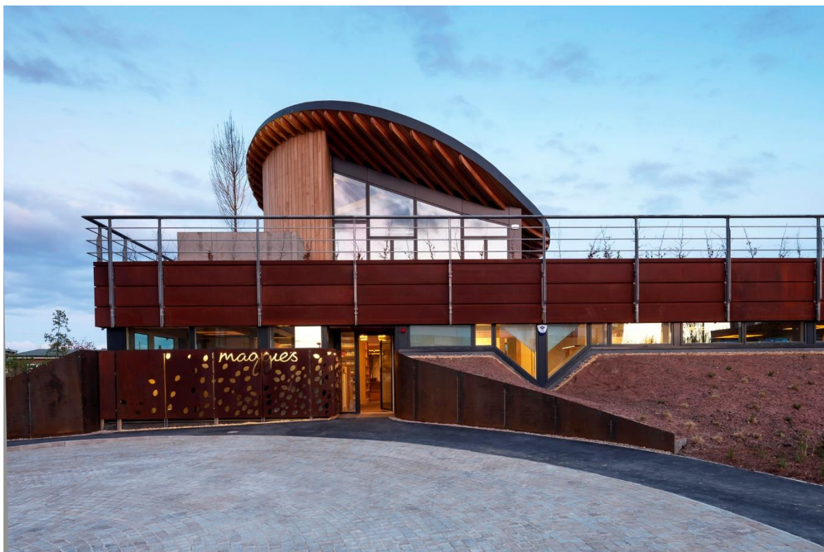
Figura 20 – Vista fachada principal do Maggie's Newcastle
