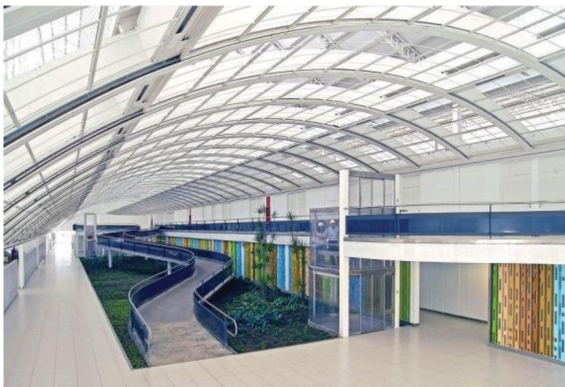
Figura 15 – Iluminação zenital na circulação da Rede Sarah – RJ
