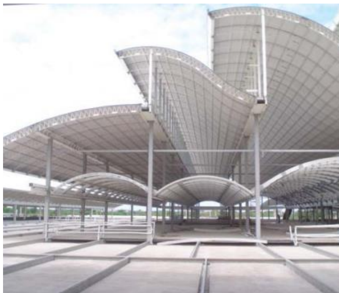
Figura 11 – Vista dos arcos móveis sob a cobertura Rede Sarah - RJ
