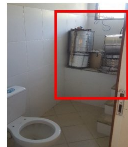
Sanitários usados como depósito.
