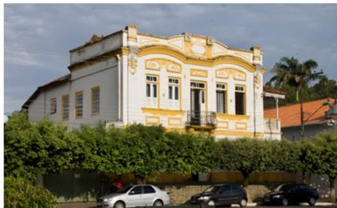
Fachada Escola Municipal de Música Sete de Setembro.
