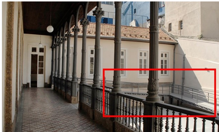
Figura 12 – Adaptações dos acessos (rampas).
