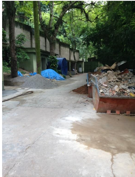
Figura 44: Entrada de serviço. Fonte: acervo pessoal da autora, 2016
