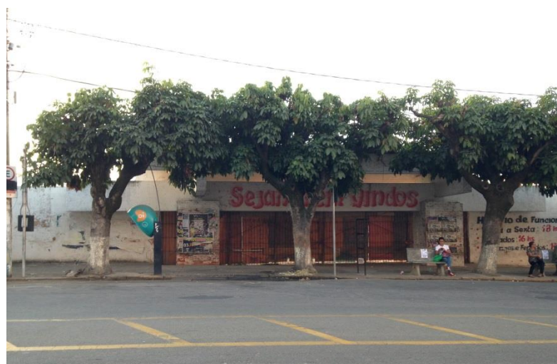
Figura 12: Vista frontal do terreno. Fonte: acervo pessoal da autora, 2016
