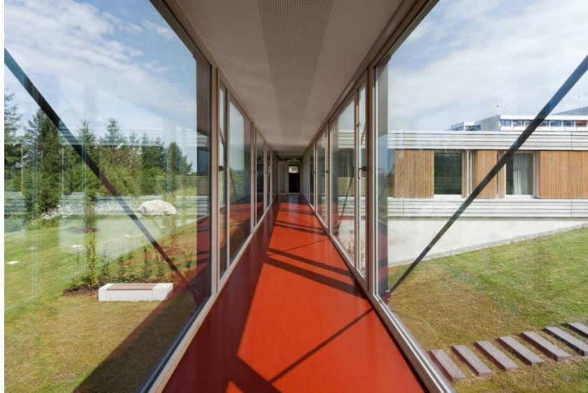
Figura 64: Corredor com fechamento em vidro. Fonte: Archdaily Site, 2016
