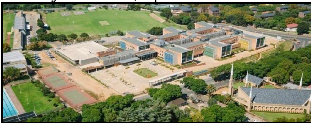
Figura 11: Vista Aérea, Hospital Infantil Nelson Mandela
