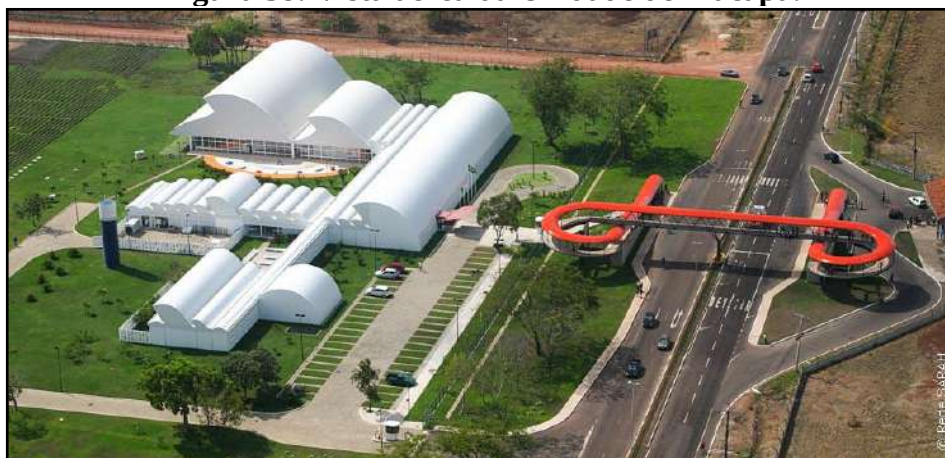
Figura 38: Vista aérea da Unidade de Macapá.
