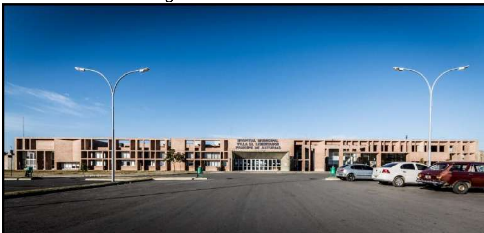
Figura 21: Vista da Fachada.
