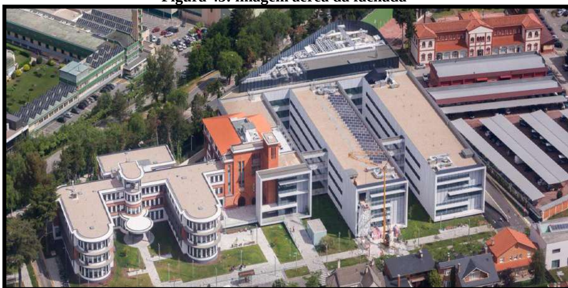
Figura 45: imagem aérea da fachada
