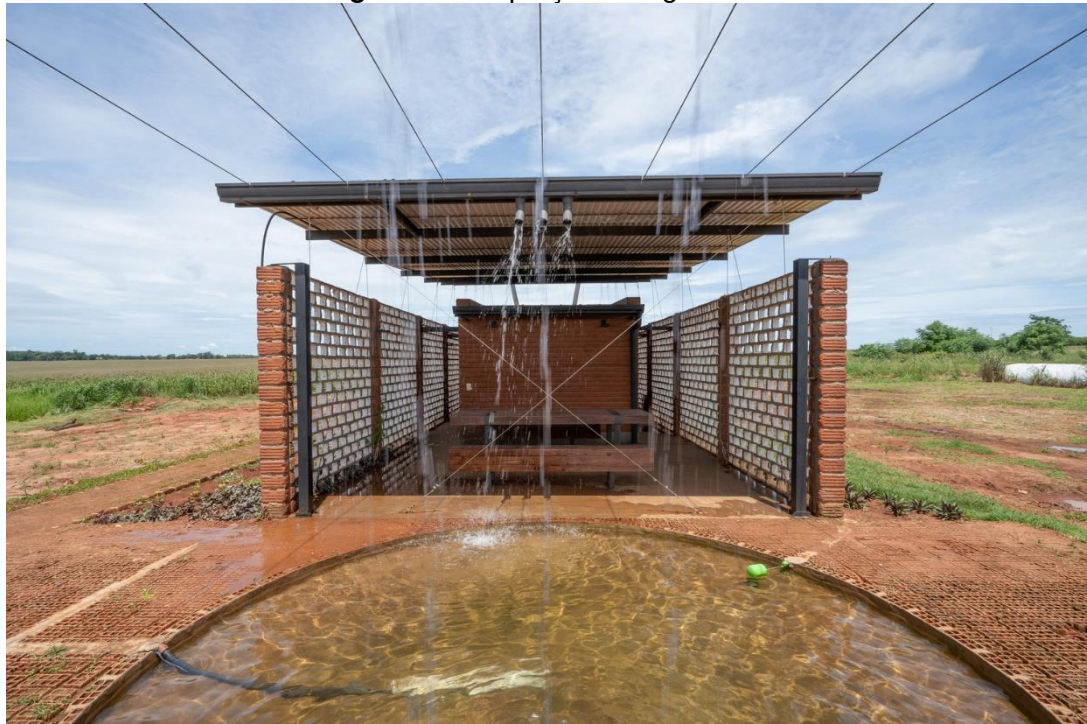
Figura 32: Captação de água
