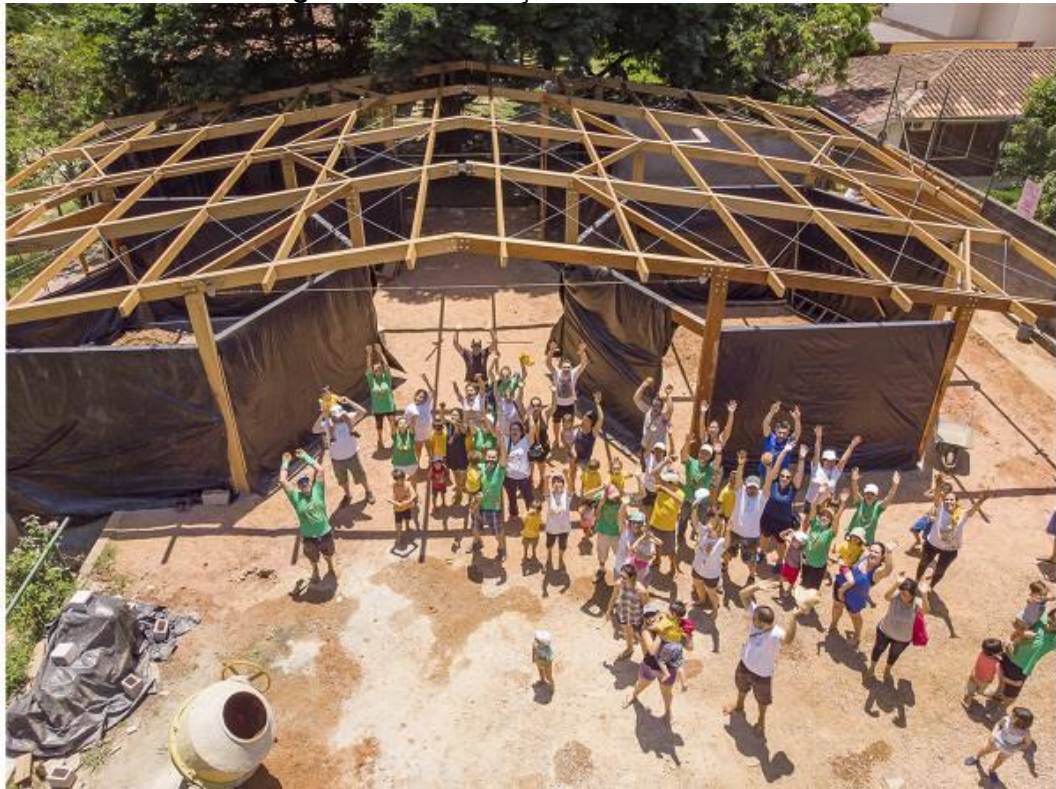
Figura 16: Construção da escola Ecoara
