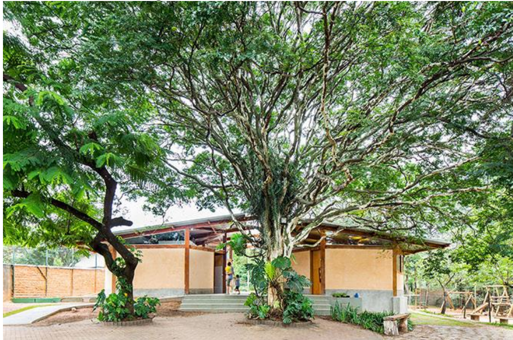
Figura 11: Fachada Escola Ecoara
