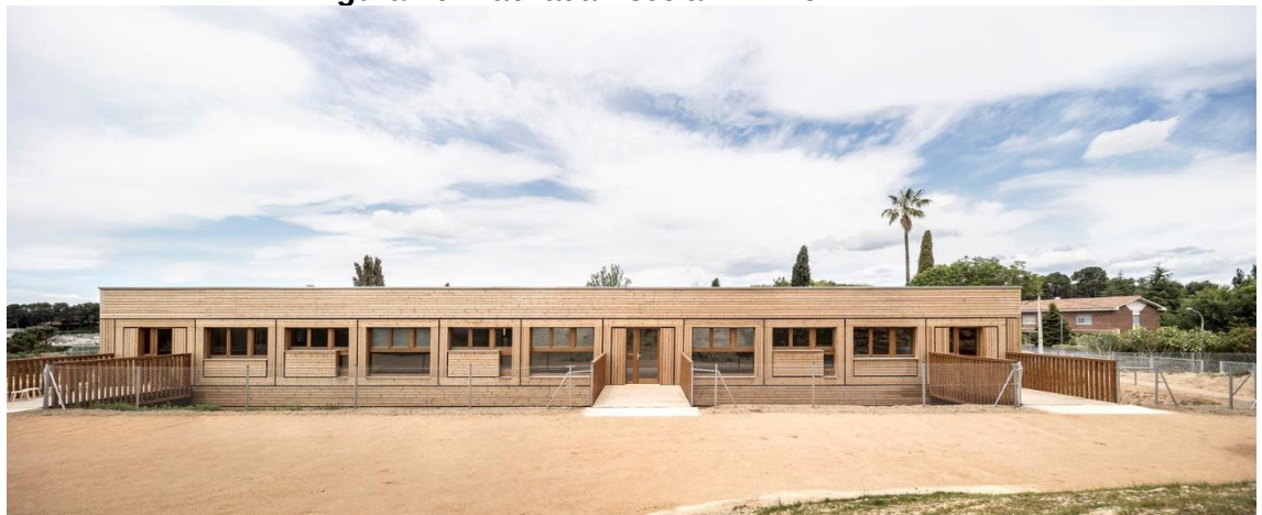
Figura 19: Fachada Escola El Til-ler
