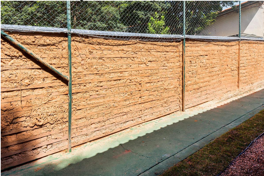
Figura 17: Parede de taipa de mão
