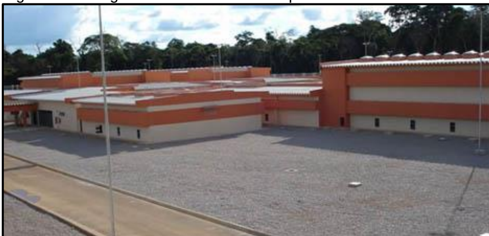
Figura 35: Fotografia do lado externo do presídio Federal de Porto Velho
