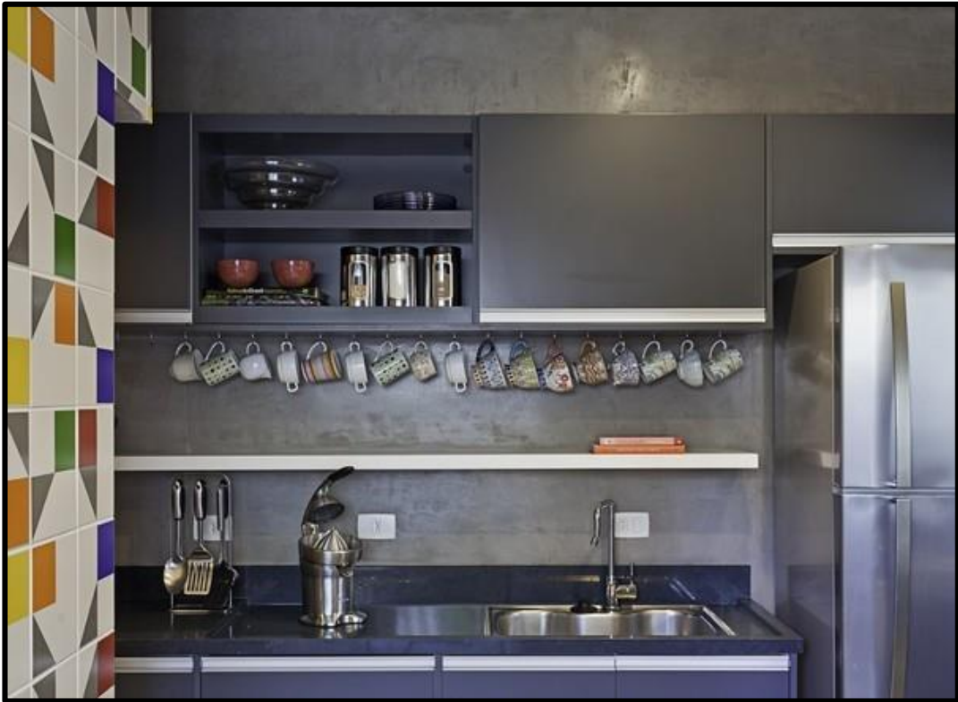
Figura 71: Fotografia de cozinha com o uso de cimento queimado
