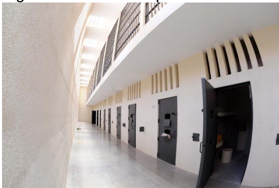
Figura 12: Fotografia das celas do presídio Federal de Porto Velho
