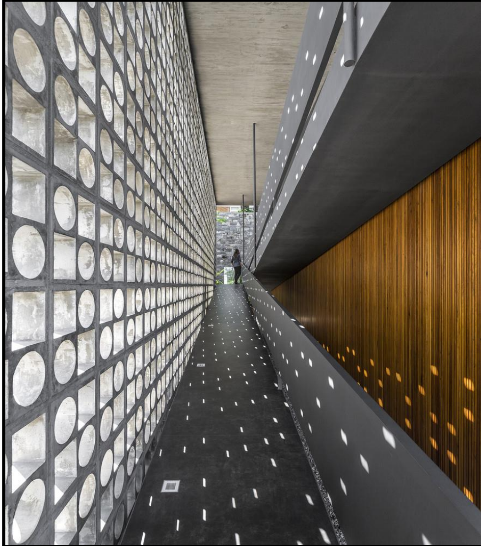
Figura 75: Fotografia de exemplo de aplicação do cobogó
