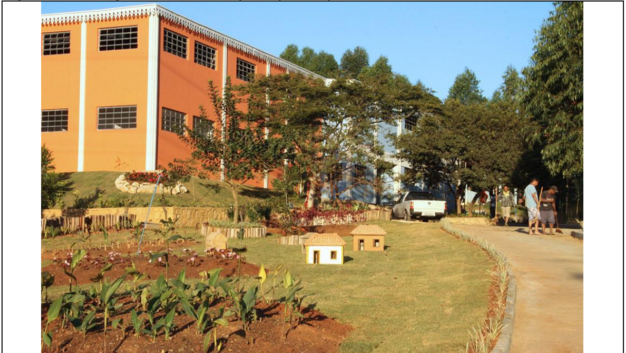
Figura 42: Fotografia do acesso principal ao prédio
