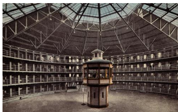
Figura 8 - Torre de vigilância do Sistema Panóptico Fonte: Lima (2005)
