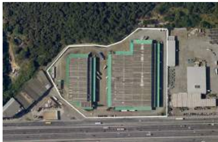
Figura 7: Imagem aérea do terreno. Fonte: Google Earth
