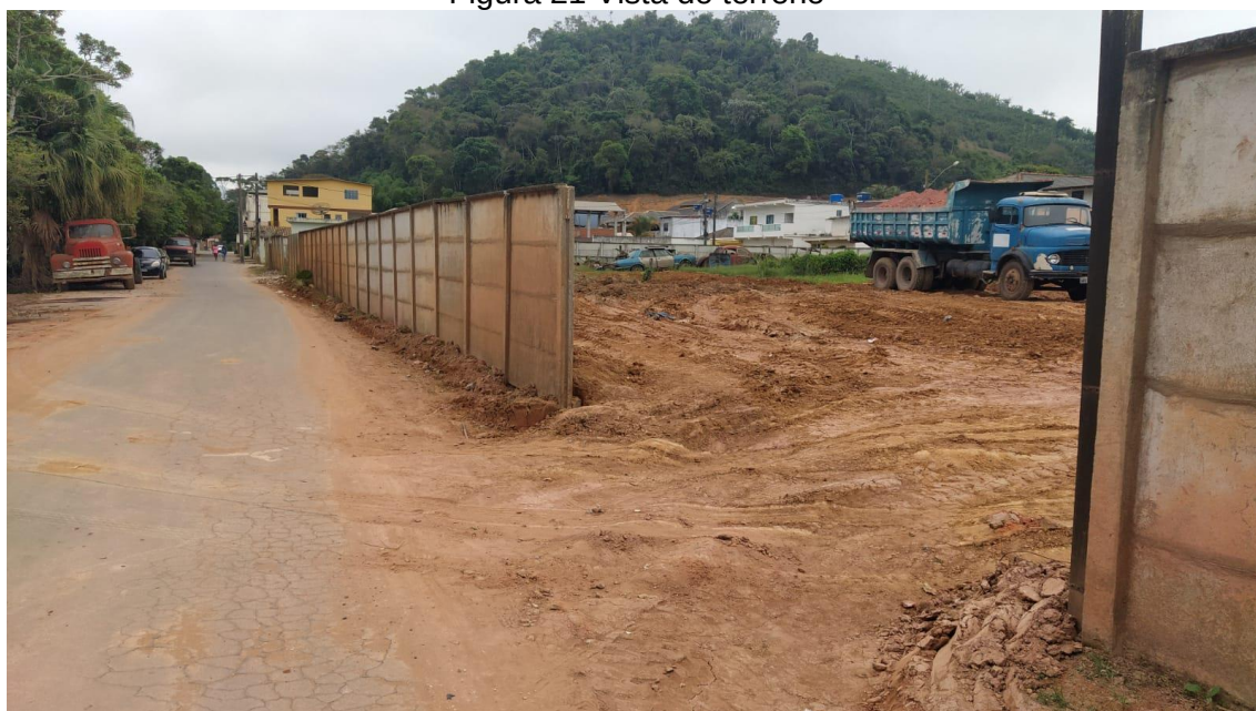
Figura 21 Vista do terreno
